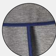
Finitions intérieures contrastées Contrasted interior finishing
